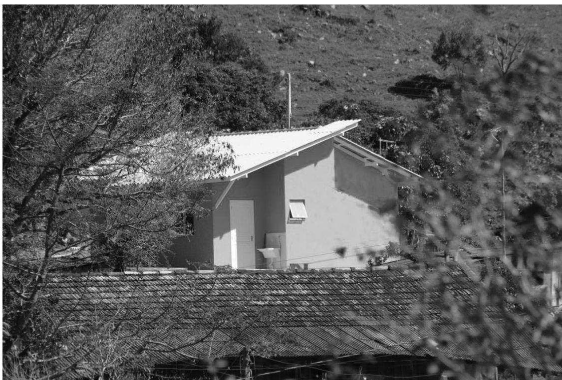
Imagem 4. Residência unifamiliar construída através do Programa Nacional de Habitação Rural (PNHR). Fonte: PET-Arquitetura UFSC
