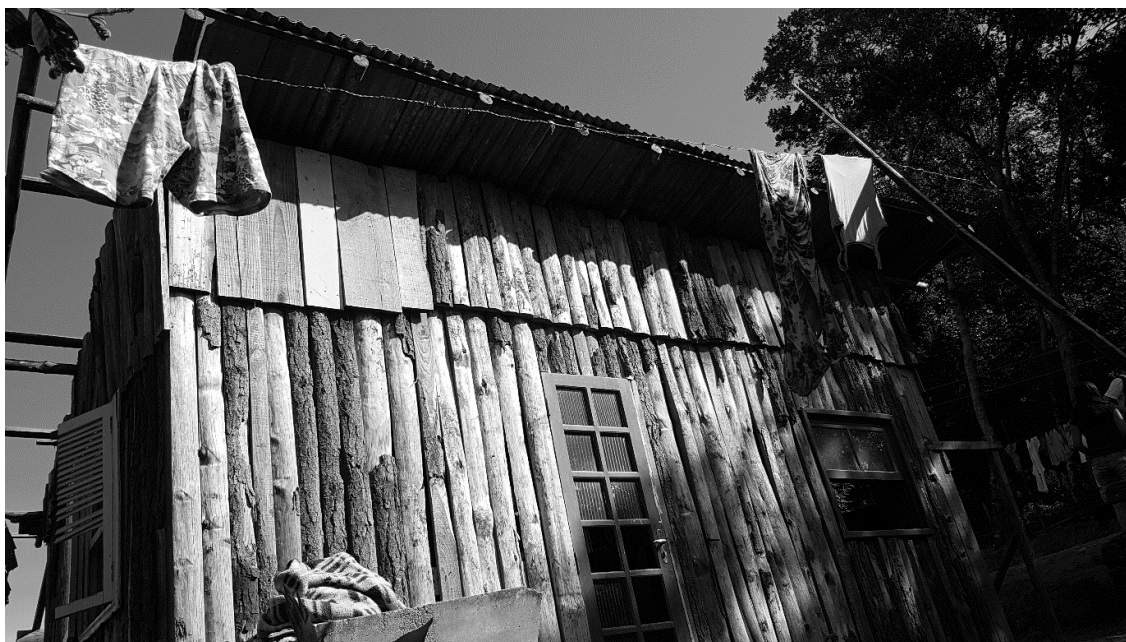
Imagem 3. Construção informal realizada pelos próprios moradores da comunidade do Quilombo Santa Cruz. Fonte: PET-Arquitetura UFSC
